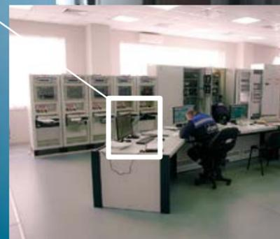
Пульт управления компрессорной станцией, оснащённый автоматическим рабочим местом оператора ДЛС
