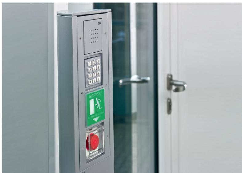
Система управления аварийными выходами TMS
