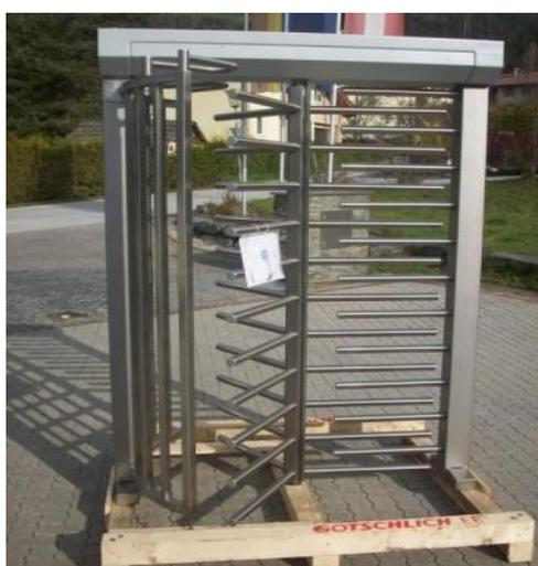
Шаг 1: Снимите упаковку и проверьте турникет на отсутствие повреждений при транспортировке
