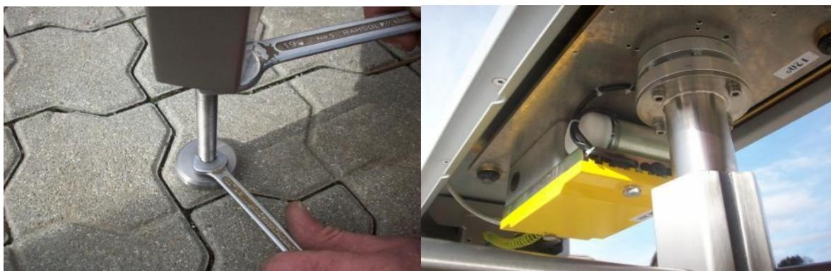
Шаг 15: Установите опорные ножки направляющих, под нагрузкой, от готового пола и закрепите с помощью контргайки. Снимите желтую крышку на блоке управления Logiturn®.
