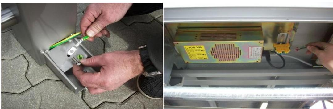
Шаг 11: Подключает клемму кабеля заземления. После этого подключите кабель питания.
