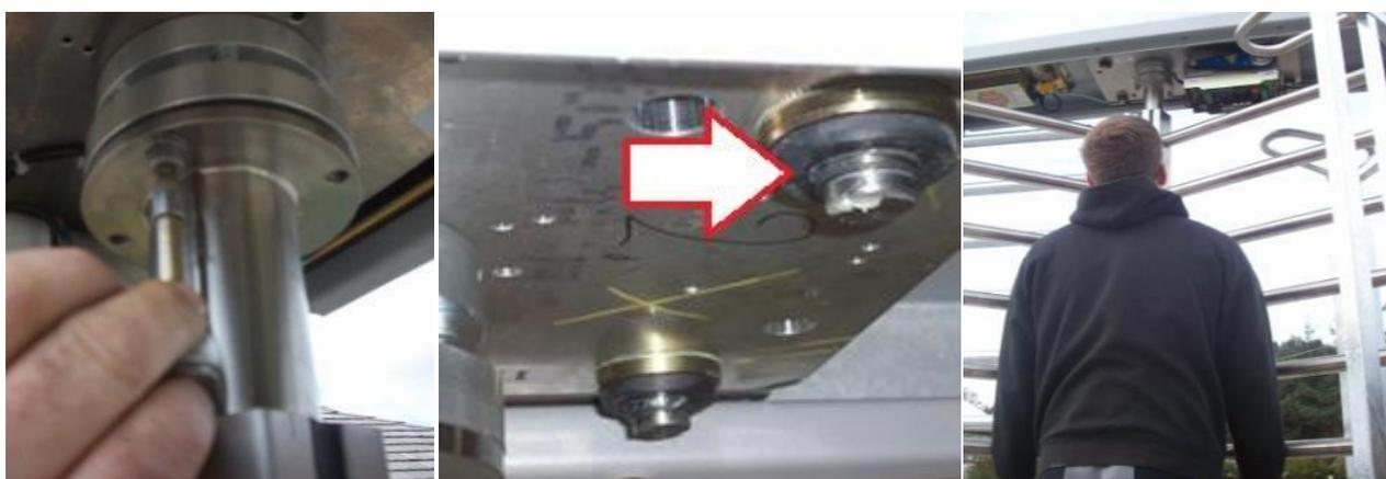
Шаг 14: Прикрутите фланец вращающегося барабана на приводной вал, проверьте что резиновые элементы зубчатой посадочной пластины имеют достаточный зазор сверху и снизу. Вращающийся барабан должен иметь возможность подниматься вместе с шестерней около 5 мм. Вращающийся барабан должен вручную проворачиваться, когда турникет находится в обесточенном состоянии.
